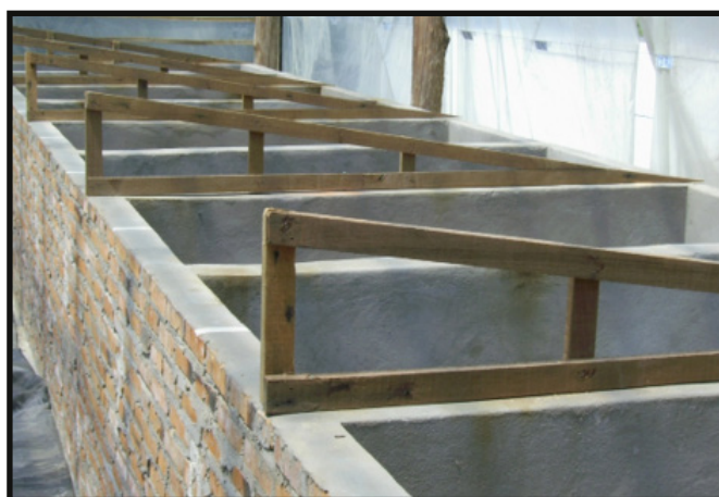
Figura 2. Detalhe dos tanques de alvenaria, onde os dejetos e a casca foram acomodados
