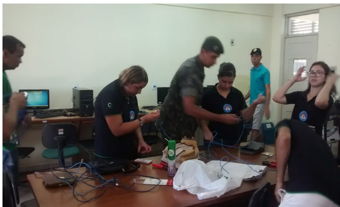
Figura 2 – Momento em que a equipe prepara patch cords para substituir os antigos daquele ambiente.
