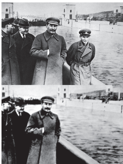
Estaline e Nikolái Yezhov em visita oficial às obras do Canal Moscovo-Volga em abril de 1937. Depois de Nikolái Yezhov ter sido julgado e executado em 1940, a censura cuidadosamente apagou-o da fotografia.
