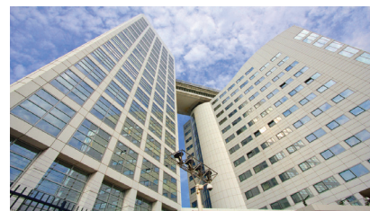
Edifício do Tribunal Penal Internacional, Haia, Holanda
