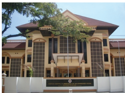
Edifício Central do Ministério da Solidariedade Social
