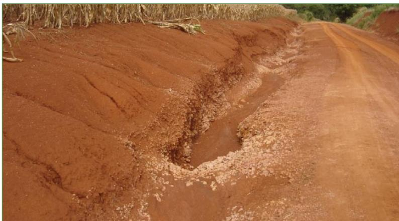
**Figura 2.11** – Formação de voçoroca na sarjeta de estrada pela ação da enxurrada (Foto: A. Doneda, 2008).
