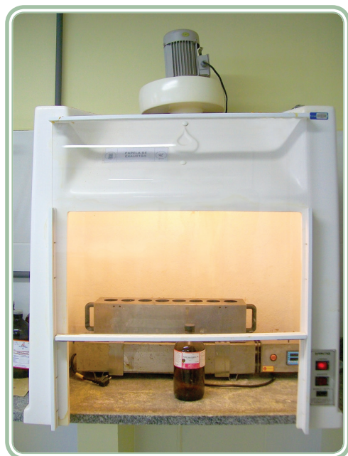
Figura 1.5: Capela com exaustão de gases para manipulação de produtos químicos
